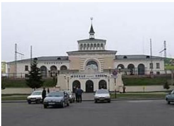
Zdjęcie 30 Dworzec kolejowy w Kowlu
